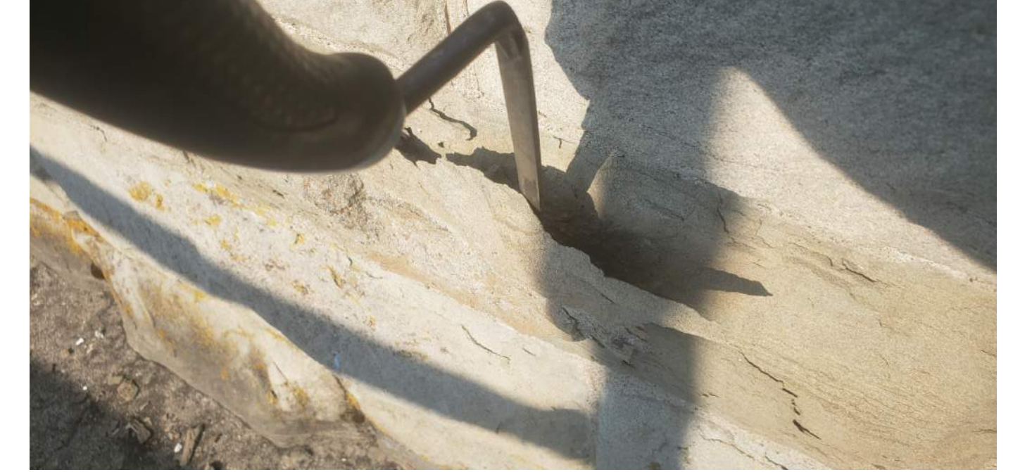
4 SPALLING FACE SCALE: NTS
